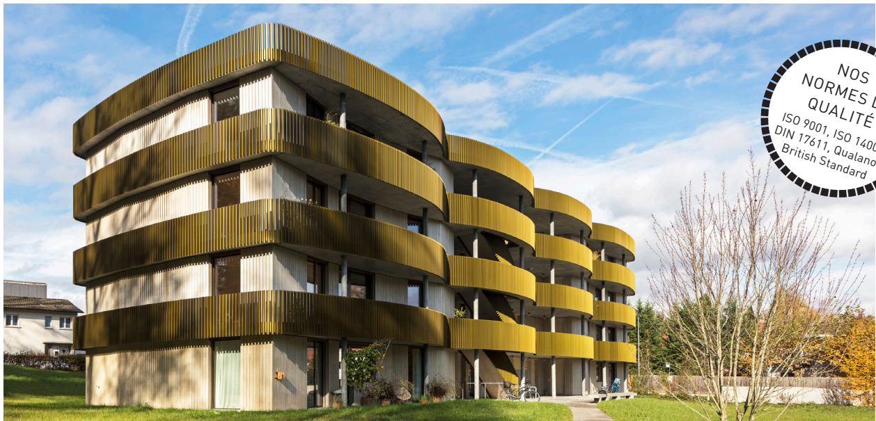
Immeubles Goldern à Aarau, architecture: Schneider & Schneider Architekten ETH BSA SIA AG, photo: Leonardo Finotti
