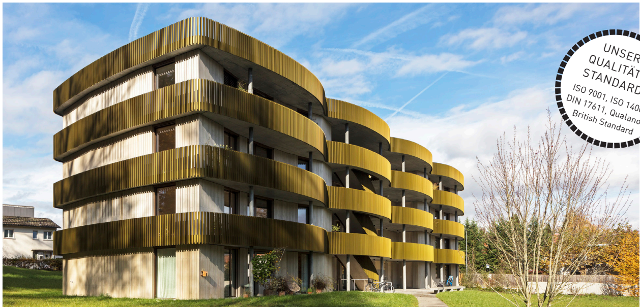
Mehrfamilienhäuser Goldern in Aarau, Architektur: Schneider & Schneider Architekten ETH BSA SIA AG, Bild: Leonardo Finotti
