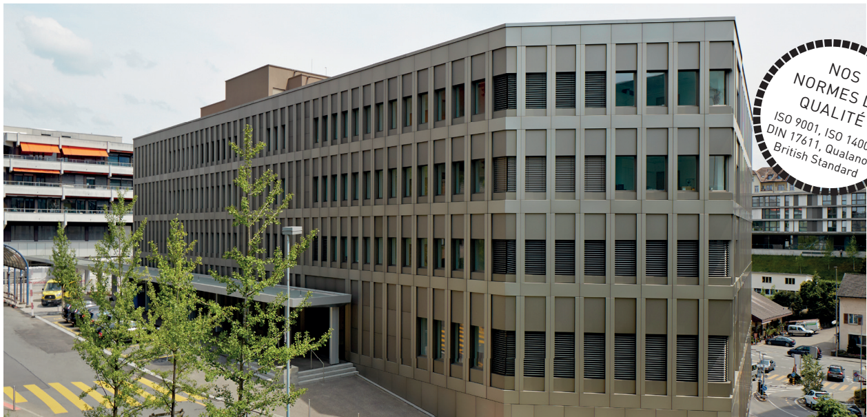
Clinique ophtalmologique de l'hôpital cantonal de Lucerne, architecture: Schneider & Schneider Architekten ETH BSA SIA AG, photo: Peter Ruggle
