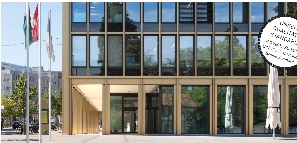
Stadthaus Kriens, Architektur: Burkard Meyer Architekten BSA, Bild: BWB Oberflächentechnik
